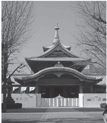
改修の始まった慰霊堂
